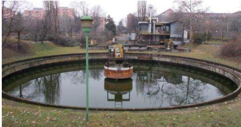
Figura 5. Vasca di sedimentazione
