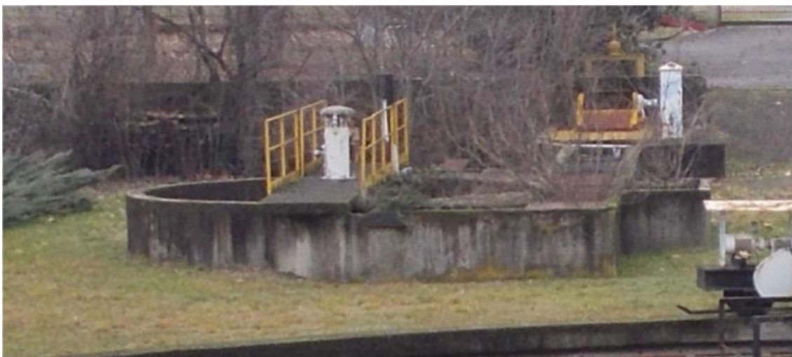
Figura 4. Vasca di dissabbiatura
