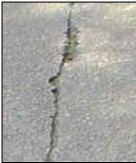
Figura 2: Esempio di fessurazione longitudinale
