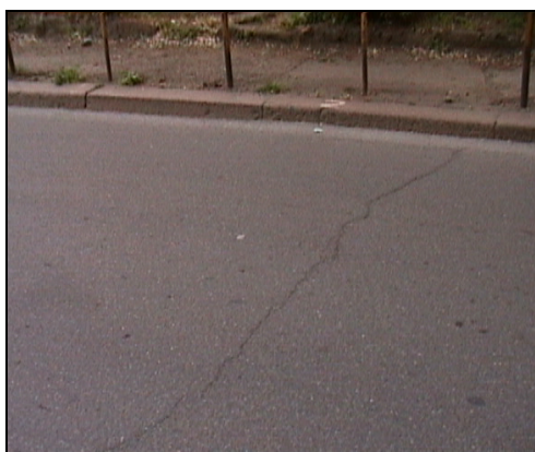
Figura 10: Esempio di fessura trasversale
