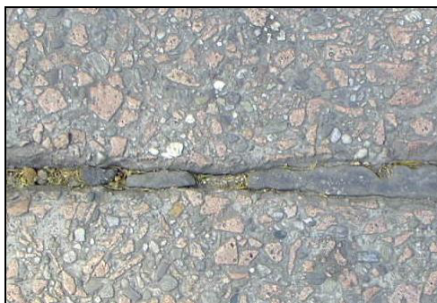
Figura 5: Degrado dei giunti precedentemente sigillati
