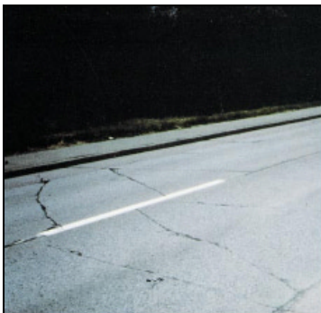
Figura 3: Esempio di fessurazione trasversale
