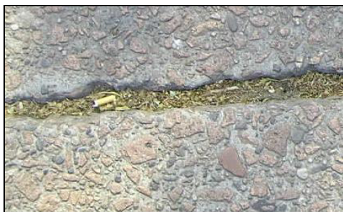
Figura 4: Degrado dei giunti non sigillati
