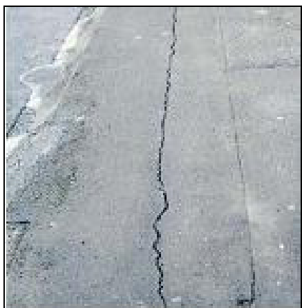
Figura 8: Esempio di fessura longitudinale
