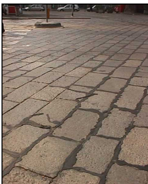
Figura 14: Spandimento di legante sul massello
