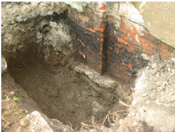
Figura 6 – Fondazioni in c.a. di pezzatura grossolana
