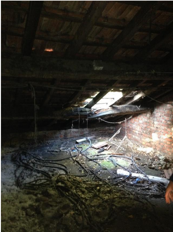
Figura 5 – Elemento ammalorato per effetto della percolazione dell'acqua
