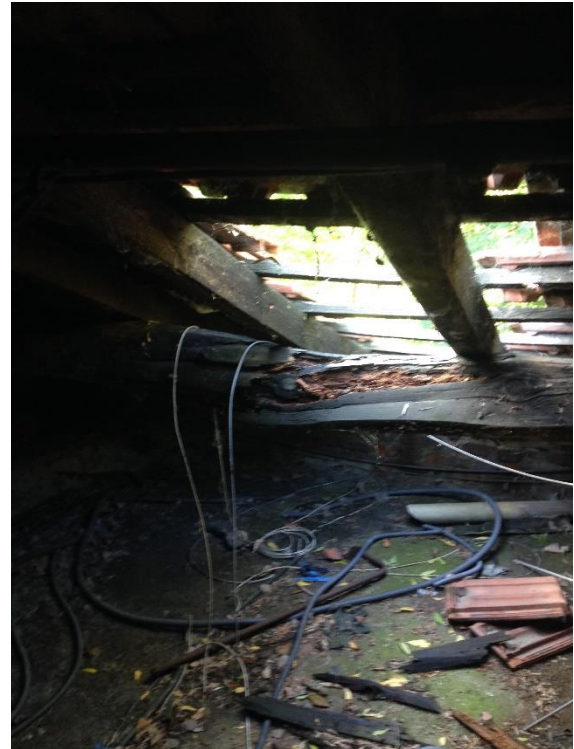
Figura 5 – Elemento ammalorato per effetto della percolazione dell'acqua
