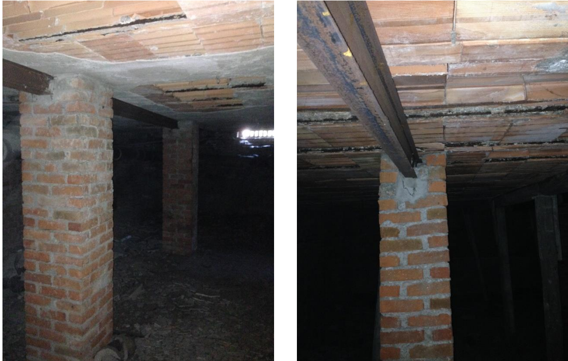
Figura 3 – Intervento di rinforzo dei solai al piano interrato
